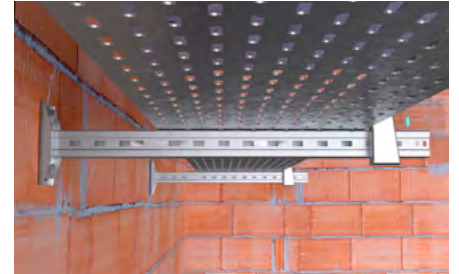
Staffaggio di impianti elettrici.
