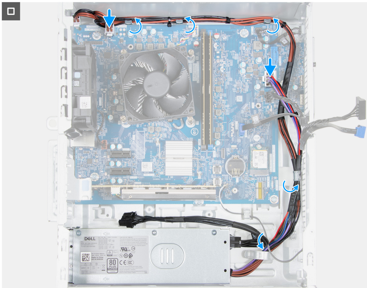
Figura 49. Installazione dell'unità di alimentazione
